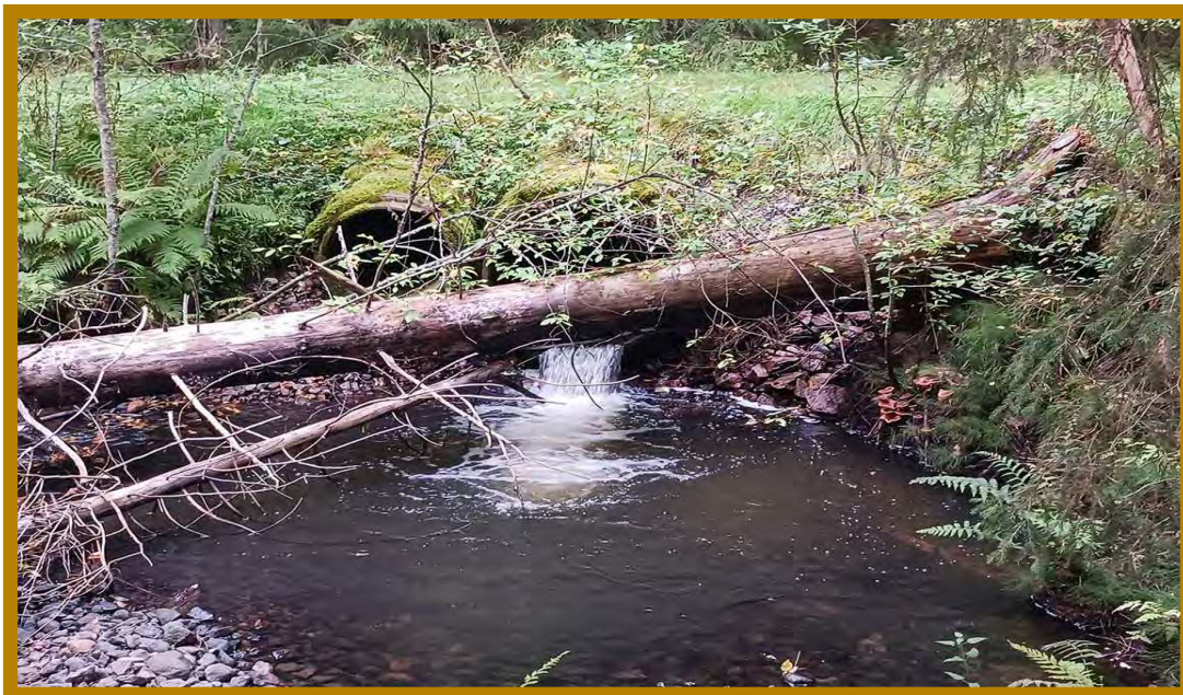
Kuva 8. Autjoen Palon kosken alueen tierummut muodostavat osittaisen vaellusesteen.
